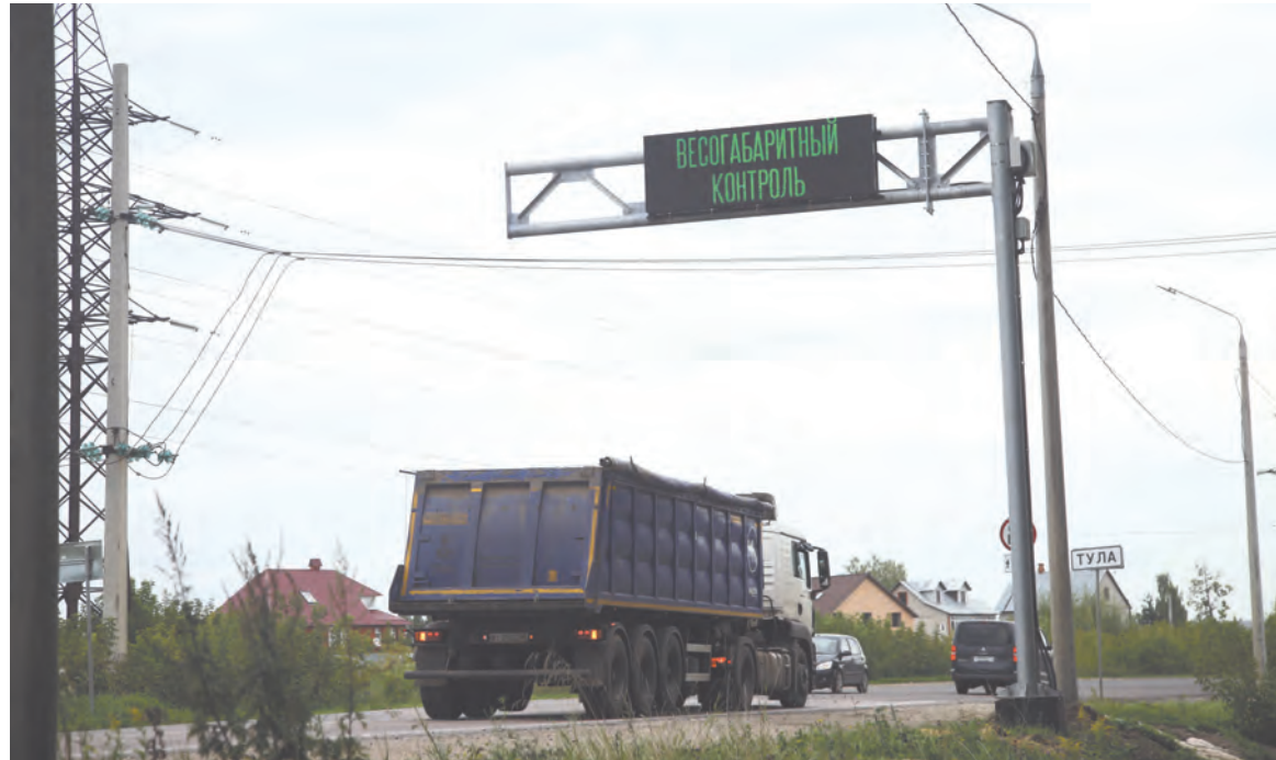
Встроенная интеллектуальная система фото- и видеосъемки АПВГК считывает весогабаритные параметры и регистрационные знаки транспортных средств
