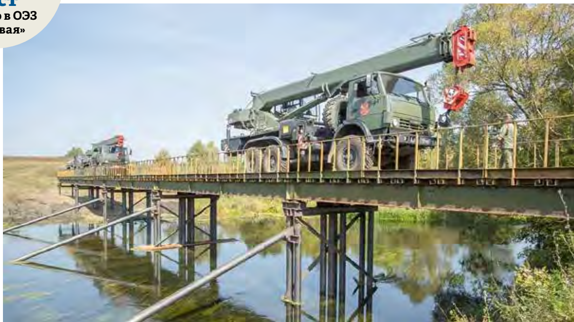
Минобороны РФ после обращения губернатора помогло в строительстве мостов
