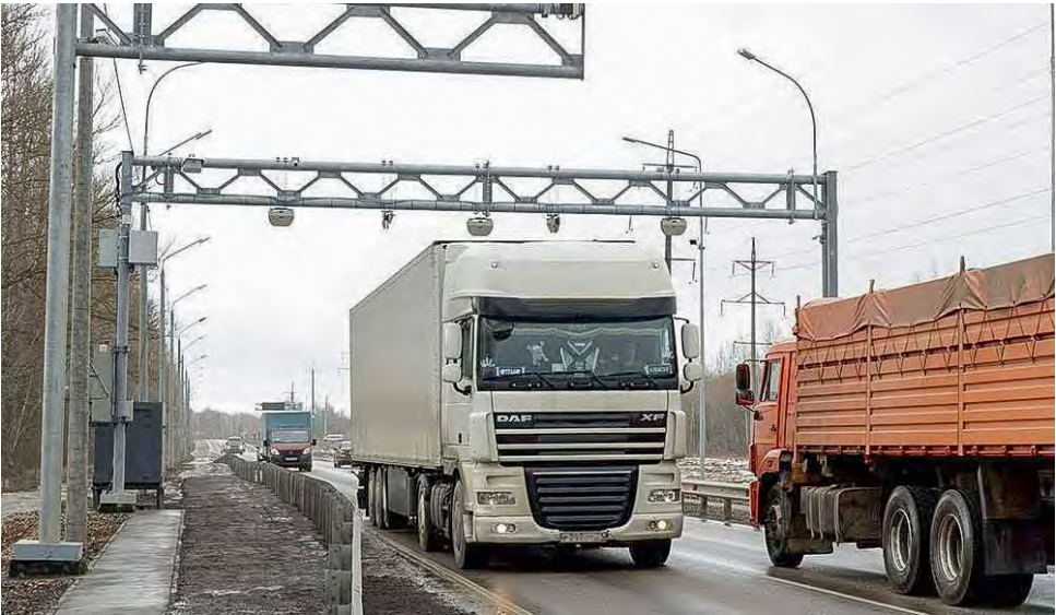
10 рамок весогабаритного контроля, установленные в Тульской области, работают в единой системе
